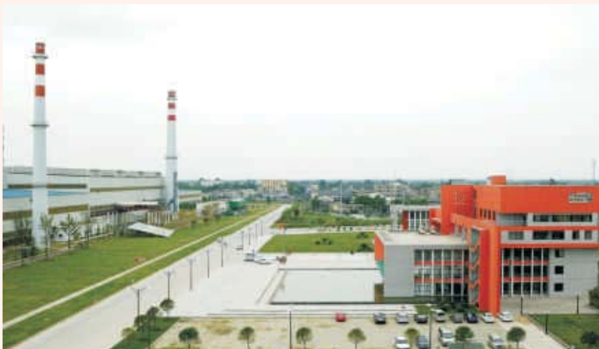
▲ 攀钢集团成都钢钒有限公司厂区
