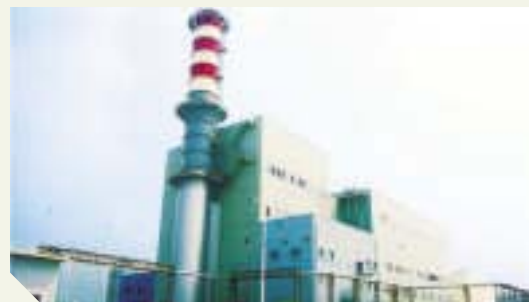
▲ 鞍钢鲅鱼圈钢铁基地CCPP工程
